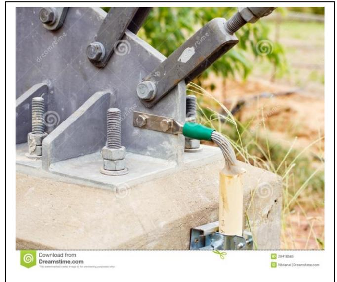
Una conexión a tierra para servicios o sistemas está diseñada principalmente para proteger las máquinas, herramientas y la aislación contra daño. Un alambre, llamado el conductor “neutral” o “a tierra”, está conectado a tierra.
